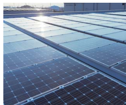
ソーラーパネルの設置
